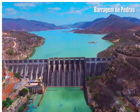
Foto 02: Captação Barragem da Pedra (Rio de Contas).
