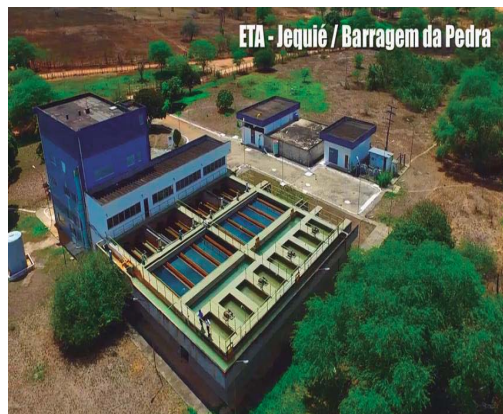
Foto 06: Unidades Operacionais ETA da Pedra.
