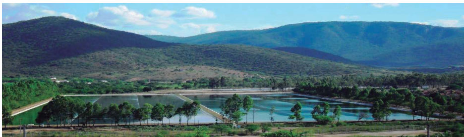
Foto 13: Estação de Tratamento de Esgoto – SES Jequié.
