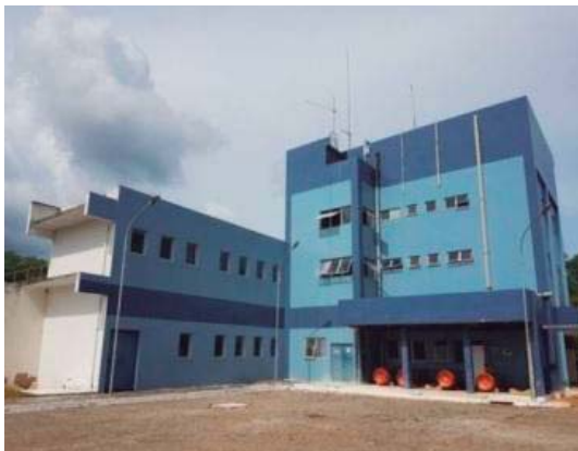
Foto 05: Fachada ETA da Pedra.
