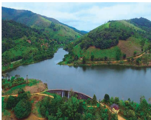
Foto 01: Captação Criciúma (Rio Preto do Criciúma).
