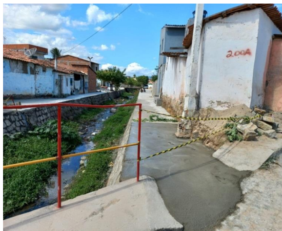
Manutenção de Diversas Estruturas em Concreto Usinado.
