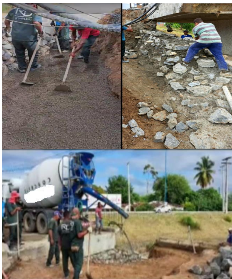
Manutenção de Pontes, Estruturas em Concreto Usinado.
