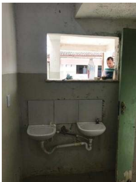
Banheiros que serão reformados com substituição de toda rede hidro sanitária
