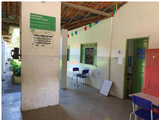
Corredor de acesso às salas que receberão nova pintura, revisão elétrica, novo piso
