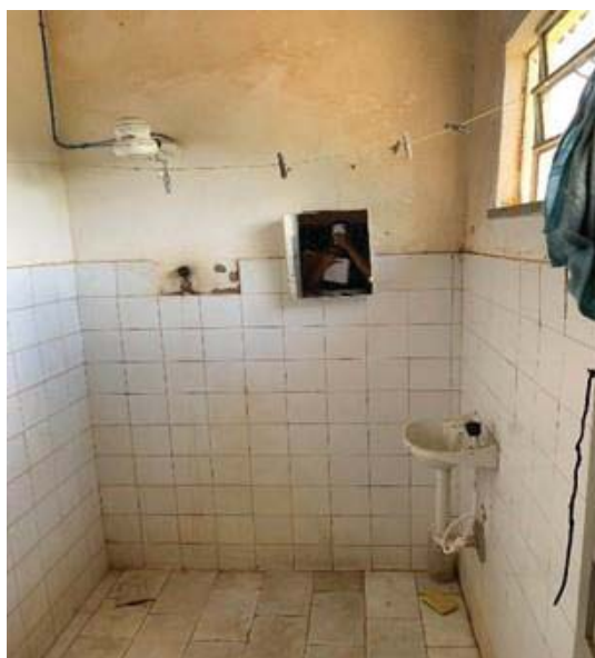
Banheiros que serão 100% reformados, com implantação de mais vasos sanitários e ampliação da quantidade de pias e chuveiros.
