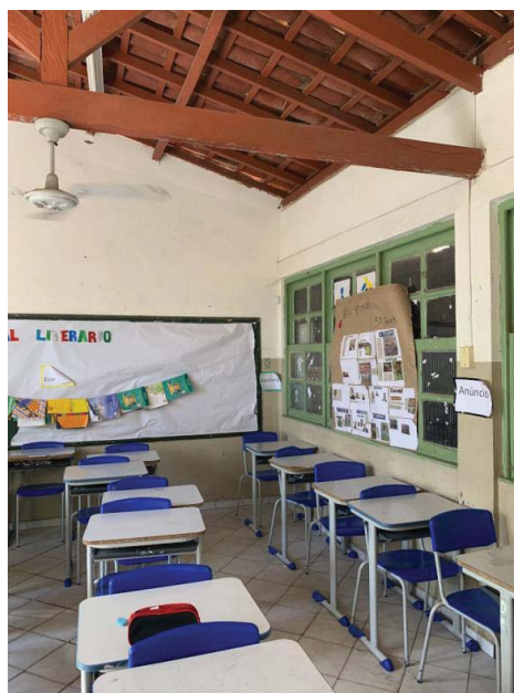
Colocação de forro nas salas de aula
