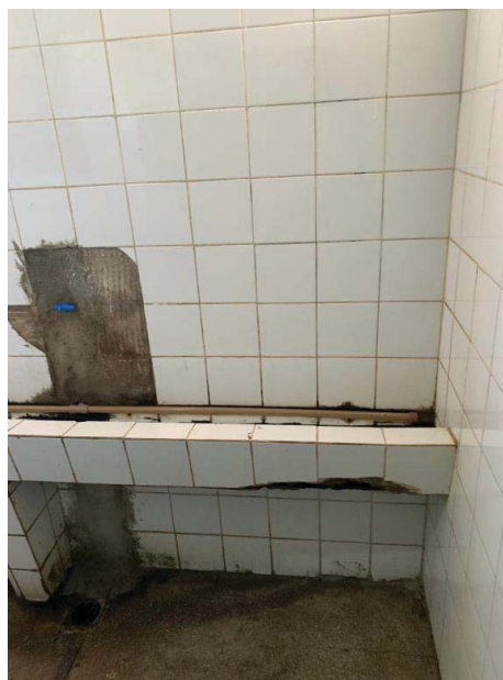
Banheiro masculino que será totalmente reformado
