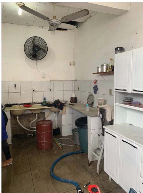
Cozinha que será reformada
