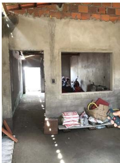
Obra já iniciada
