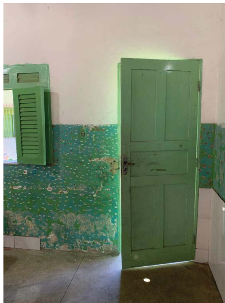
Sala de aula que receberá revestimento nas paredes
