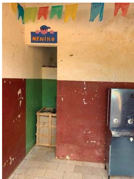
Acesso ao banheiro masculino que será revitalizado.
