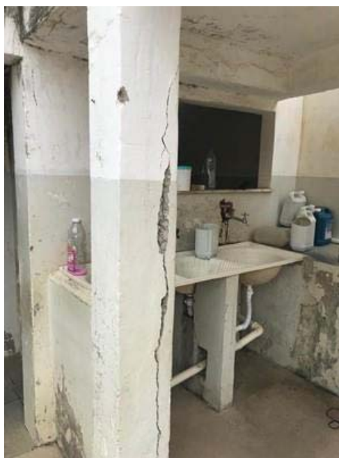
Recuperação estrutural do reservatório elevado
