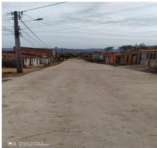
Depois – Rua Alto da Igreja – Km 4
