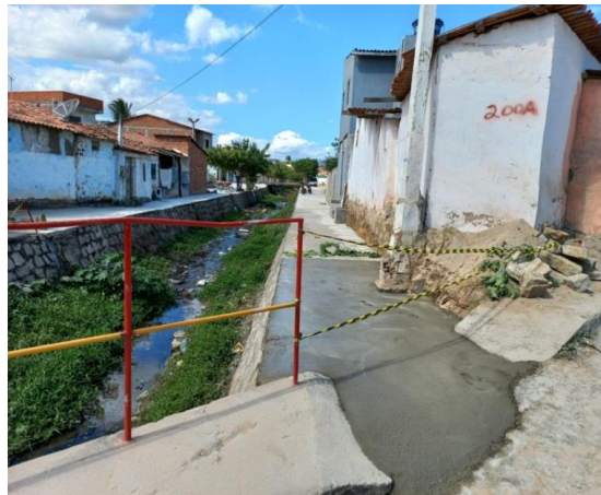
Manutenção de Diversas Estruturas em Concreto Usinado.
