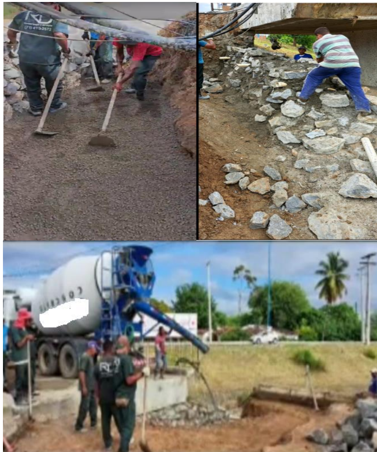
Manutenção de Pontes, Estruturas em Concreto Usinado.
