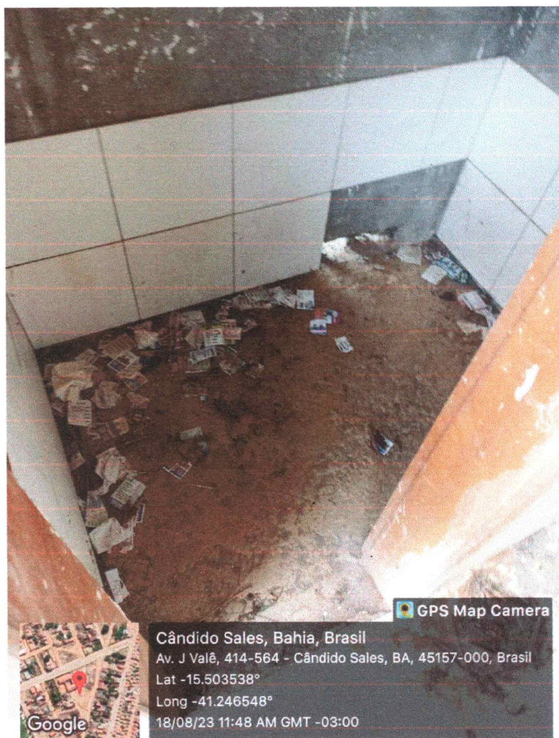
Sala técnica parcialmente executada.
