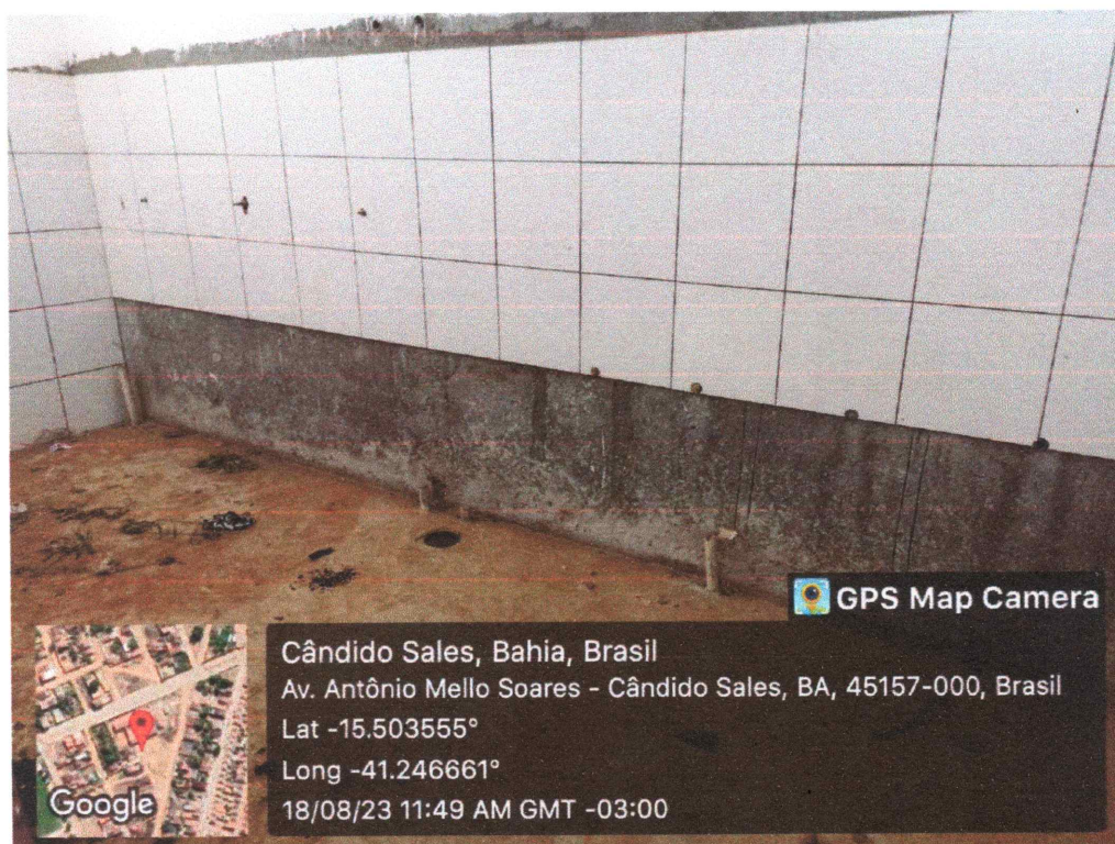
Área dos sanitários parcialmente executada.
