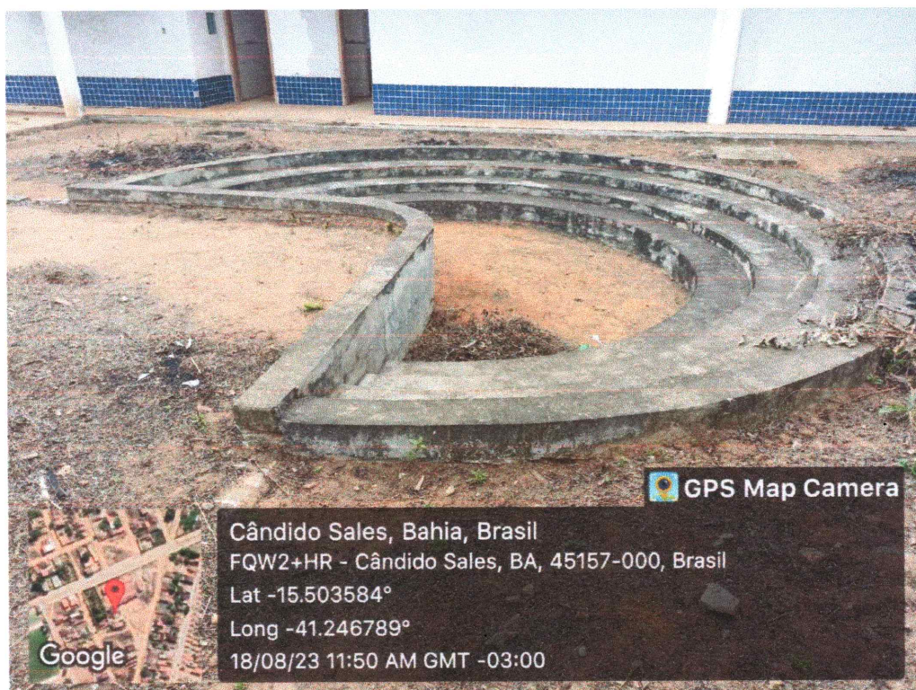
Anfiteatro construído parcialmente.
