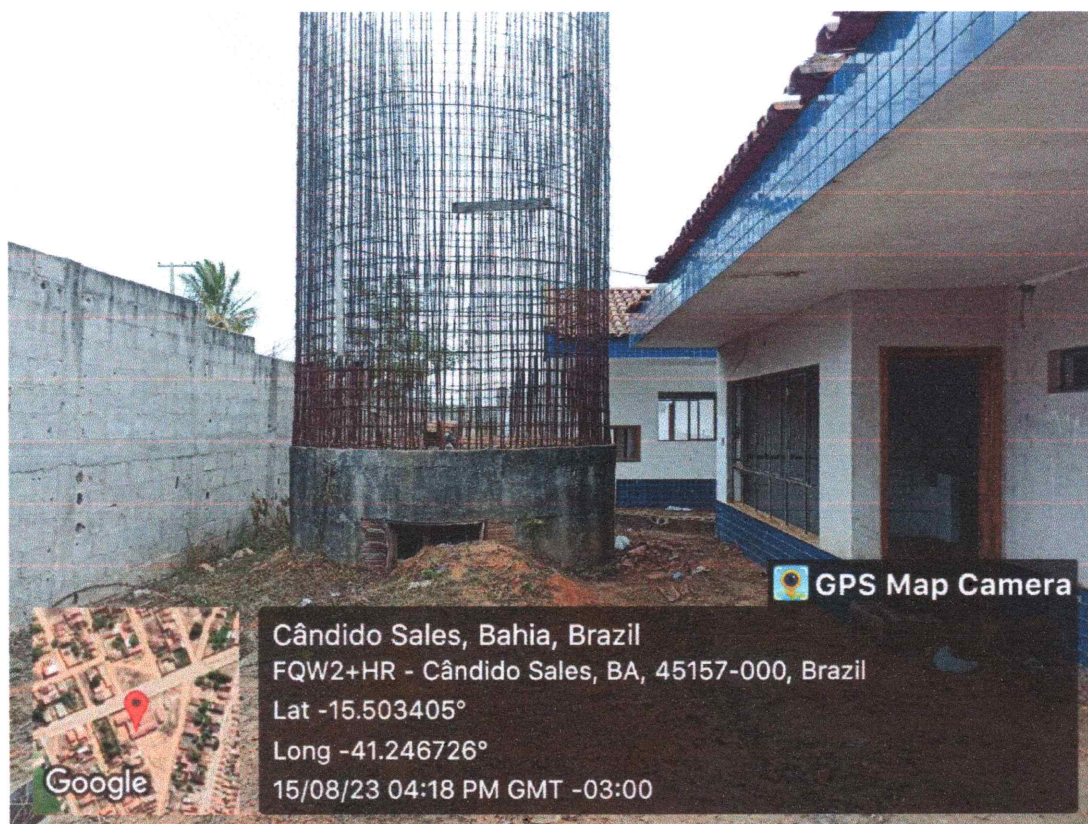
Estrutura do Castelo d'água.
