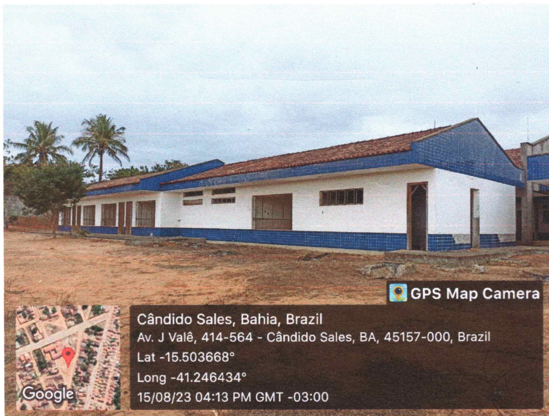
Parte lateral da edificação que engloba salas técnicas, Lab. Informática, Sala de Leitura, pré-escola, entre outros.
