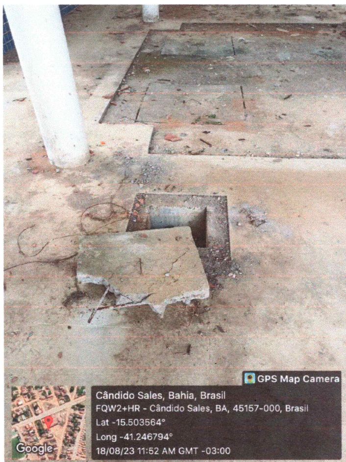
Tampa de caixa de inspeção
