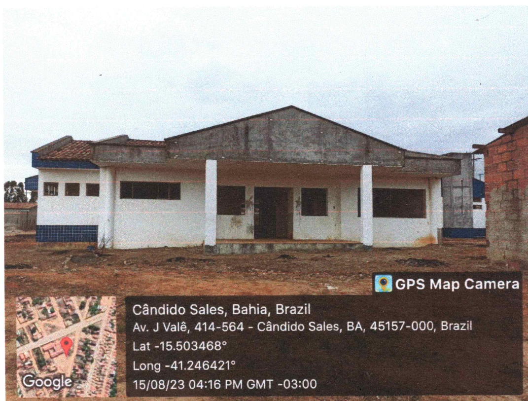
Bloco administrativo da creche.
