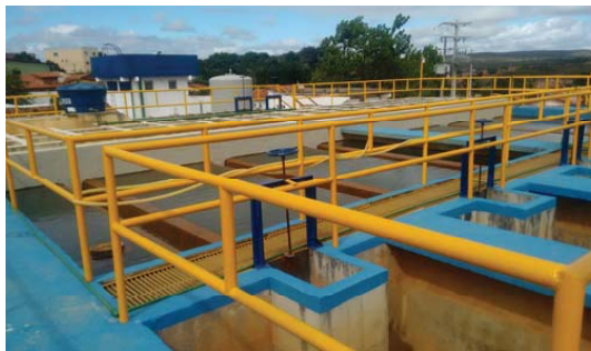
Foto 03 – Vista dos floculadores e decantadores
