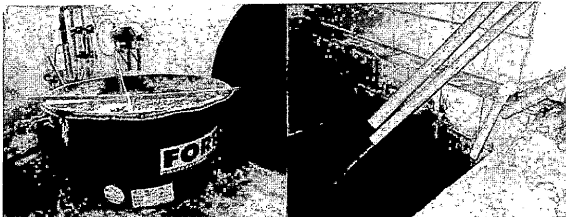
Figura 6–Produção de solução de cloro e aplicação conjunta com ácido fluossilícico
