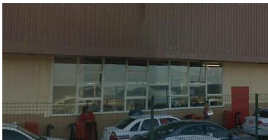
10.3. As esquadrias fixas de alumínio pintado cor branca/ vidro temp. inc. 10 mm que ficarão em contato com o meio exterior, deverão ser estanque a água e ao vento. A chapa de vidro deverá ser colocada por profissional especializado, e de tal modo que não sofra tensões suscetíveis de quebrá-la e ter folgas em relação as dimensões de rebaixo. O vidro deverá atender as condições estabelecidas na NBR-11706 e NBR-7199.
