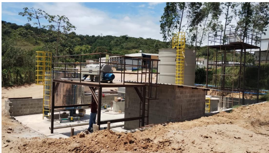
Foto 01: Implantação de sistema primário - flotador.
