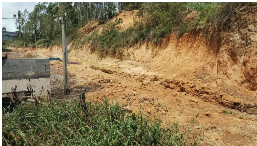
Foto 04: Vala aberta para drenagem de água pluvial.
