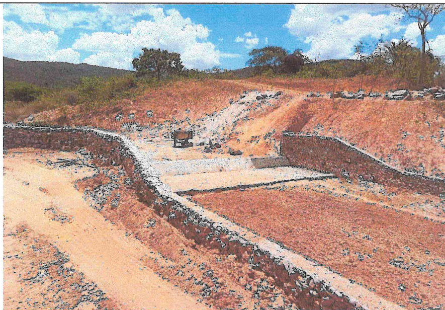
Foto 02: Construção de barreiro na Fazenda Paz.
