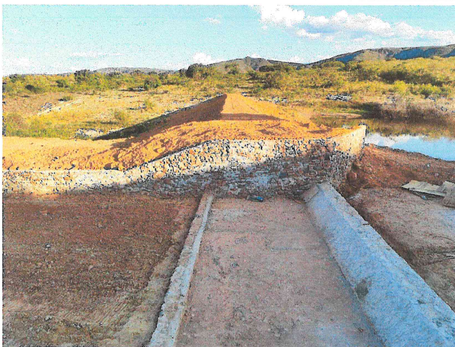
Foto 07: Construção de barreiro na Fazenda Paz.
